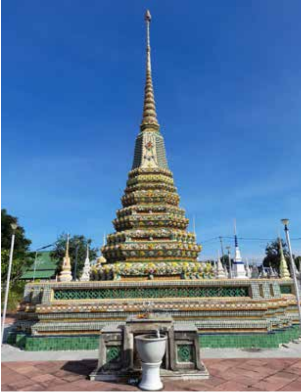
วิหารพระพุทธไสยาสน์ ขนาดกว้าง ๖.๕ เมตร ยาว ๑๙.๐๘ เมตร เป็นอาคารคอนกรีตเสริมเหล็ก มีลักษณะแบบโบราณหน้าบ้านมีขนาดใหญ่
