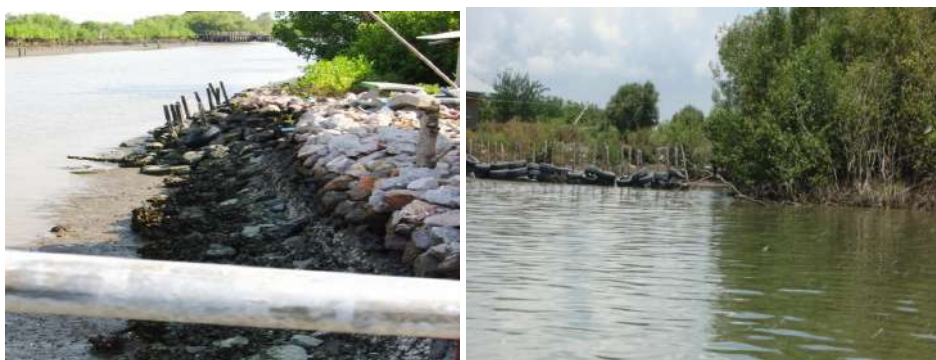
ภาพที่ 20 เทคโนโลยีท้องถิ่นป้องกันการกัดเซาะชายฝั่งของชุมชน
