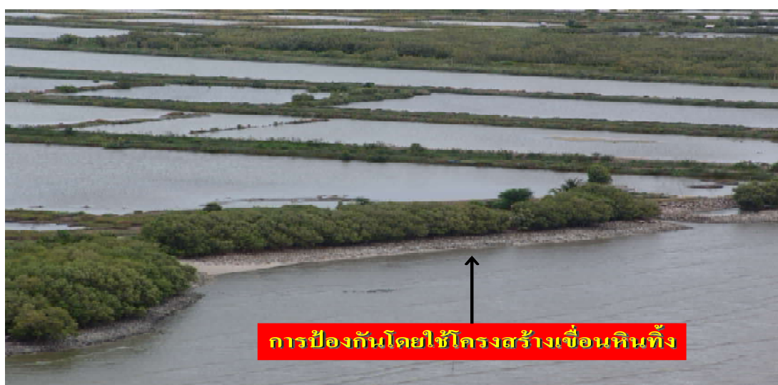
ภาพที่ 10 เขื่อนหินที่ชาวบ้านใช้ป้องกันการกัดเซาะชายฝั่งพังทลาย
