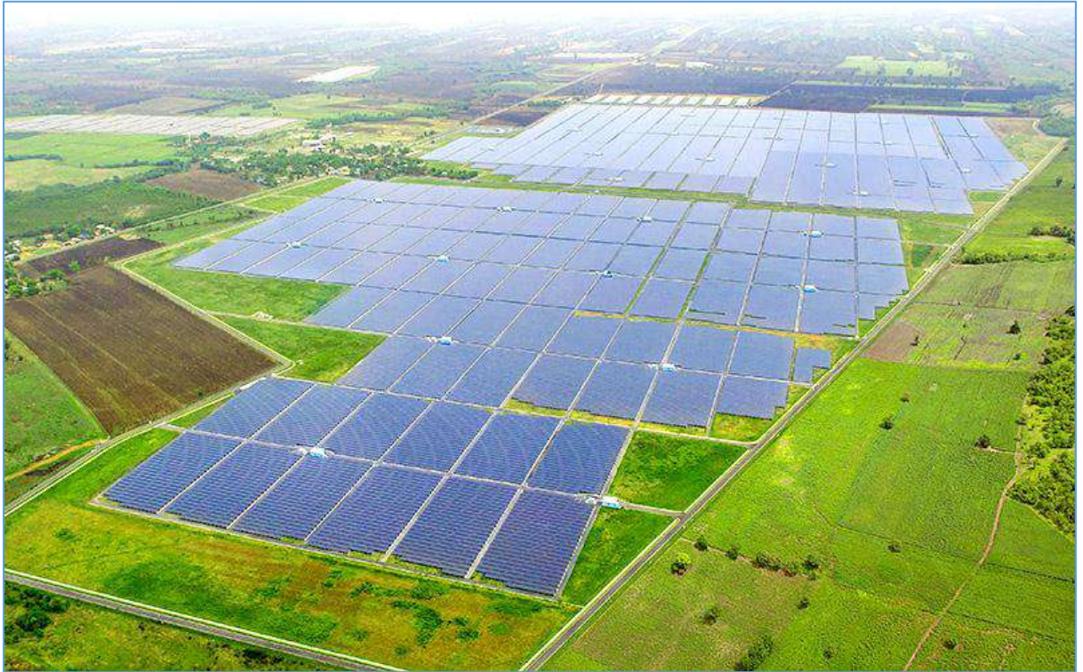
โรงไฟฟ้าพลังงานแสงอาทิตย์กำลังผลิต ค เมกะวัตต์
